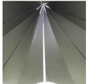
Tête de mât fixée dans la bâche pour protéger le faitage
