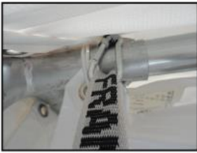
Vue de la panne sous la bâche de toit avec une sangle
