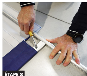
ÉTAPE 8 Serrer les vis de maintien du cadre grâce à la clé Allen fournie.
