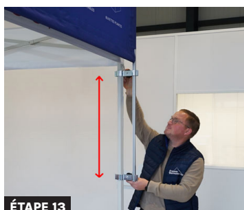
ÉTAPE 13 Ajuster les connecteurs et visser fermement pour un bon maintien.
